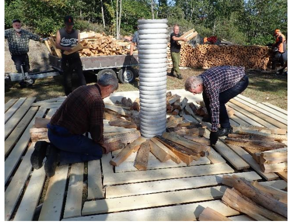
Rist lagt rundt tennkanalen.
